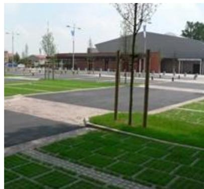
Exemples d'aires de stationnement en revêtements perméables pour un usage **fréquent** :
